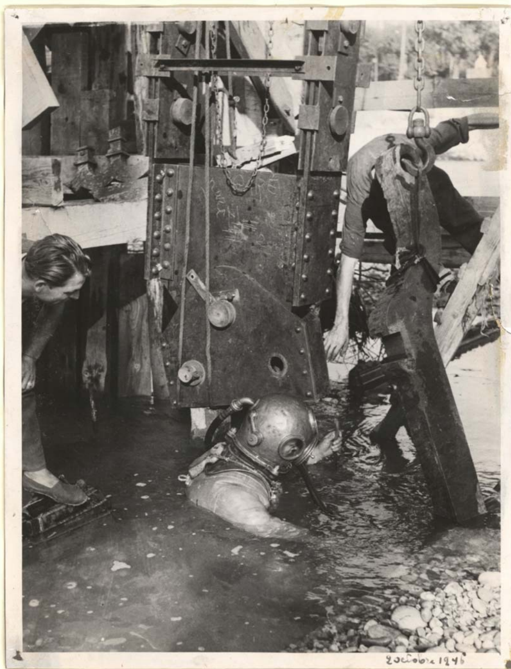
Plongeurs pour la construction des semelles de piles du pont MORAND , le 2 octobre 1946 (Archives D.D.E)
